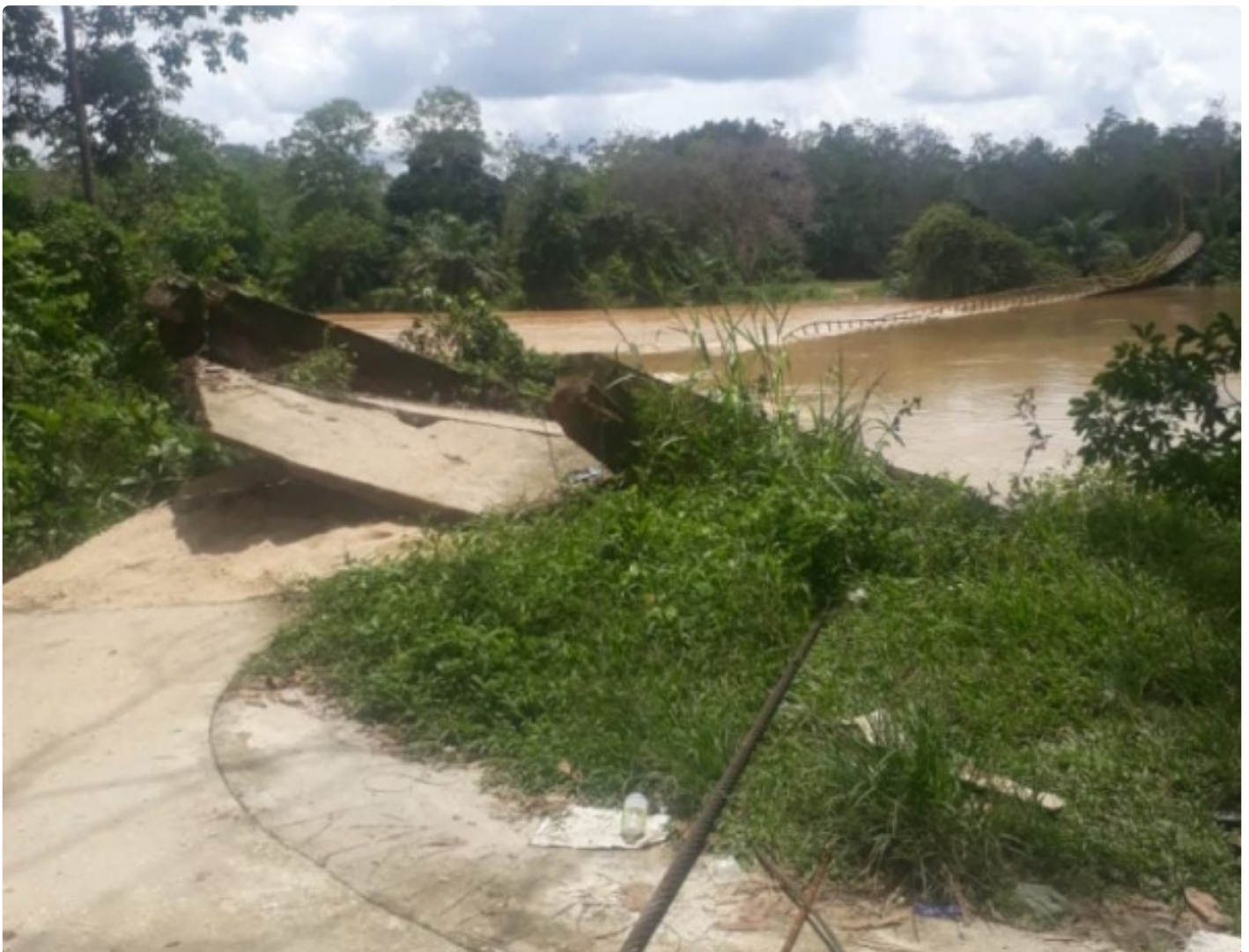
Jembatan Penyebrangan Ambruk
